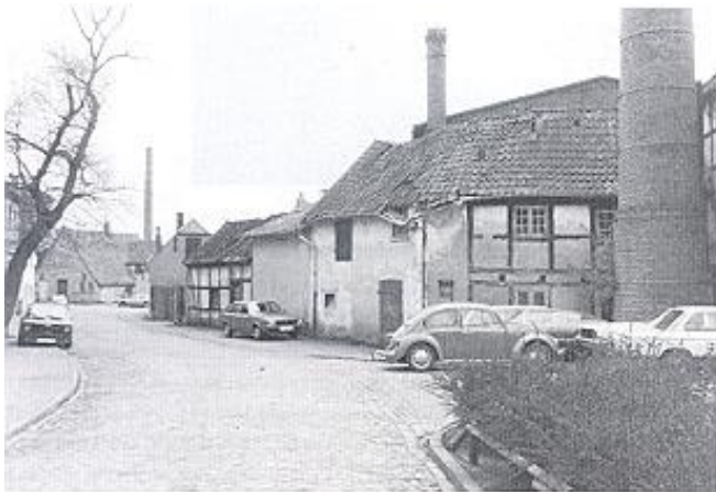
Dem Verfall preisgegeben: die Gebäude in den 1970er Jahren
