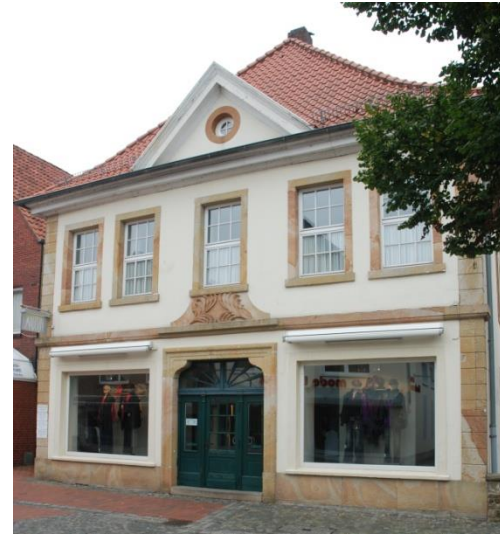
Eines der schönsten Bramscher Häuser an der Großen Straße: klassizistisch mit Walmdach und Frontspitzgiebel. Besonders sorgfältig ist die mit Palmblättern gezierte Portalbekrönung gestaltet.
